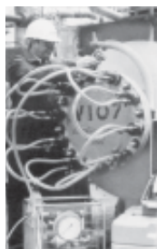
Stud tensioning
